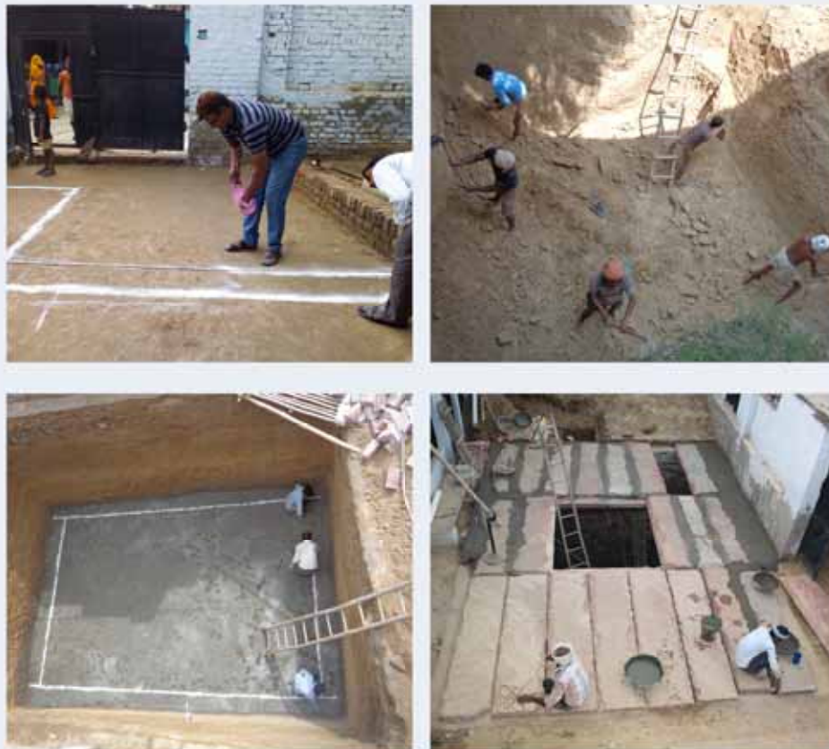
चित्र 1: आर. डब्ल्यू.एच. निर्माण प्रक्रिया, प्राइमरी स्कूल, नगला टीन
