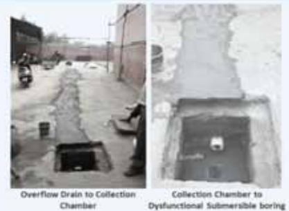
चित्र 12: टंकी से रिचार्ज बोरिंग के लिए अतिप्रवाह (ओवरफ्लो) नाली का निर्माण
